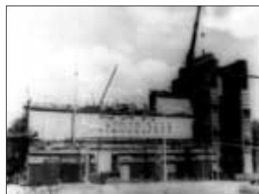
Строительство стенда В3
